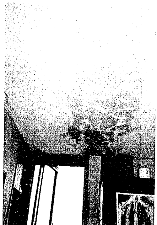
高層棟天井雨漏り
