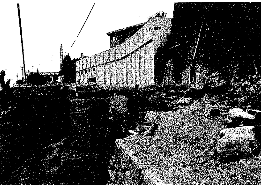
がけくずれによる 災害現場 (大統領官邸前)
