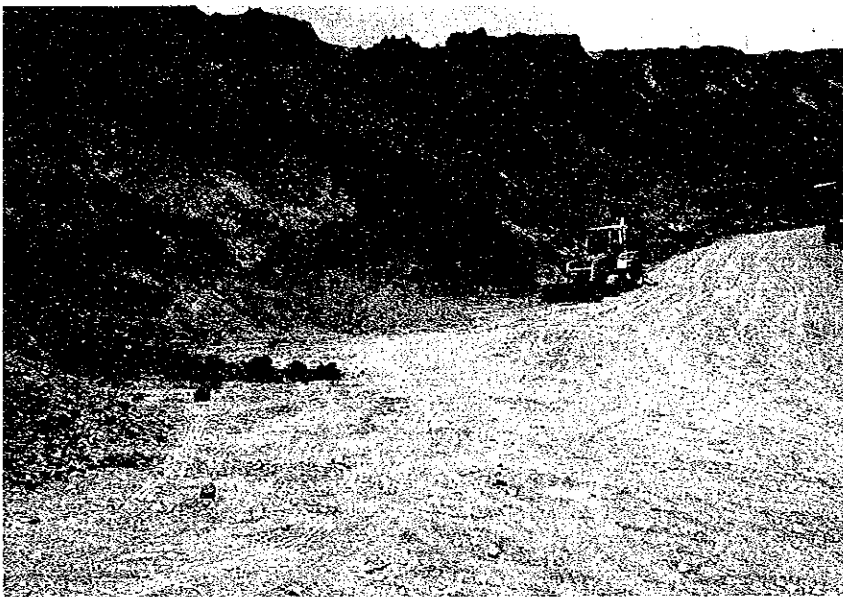
崩落土砂の撤去作業
