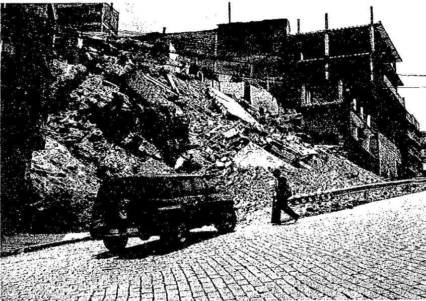
地すべりによる災害現場 とブロック敷道路
