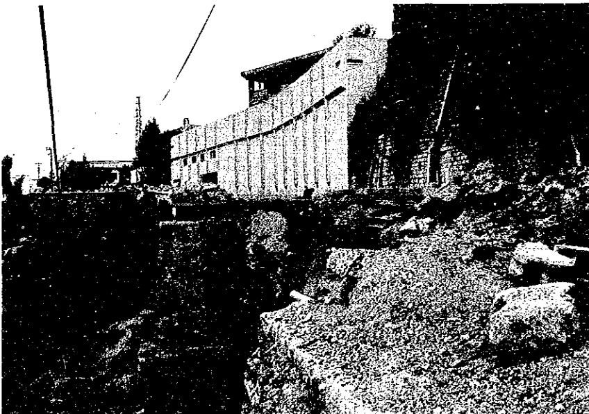
Lugar dañado por el derrumbamiento de tierra (delante de la Residencia Oficial del Presidente)
