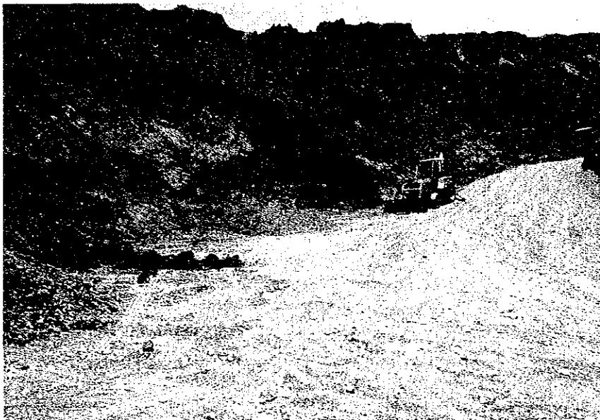
Trabajo de remoción de tierra derrumbada
