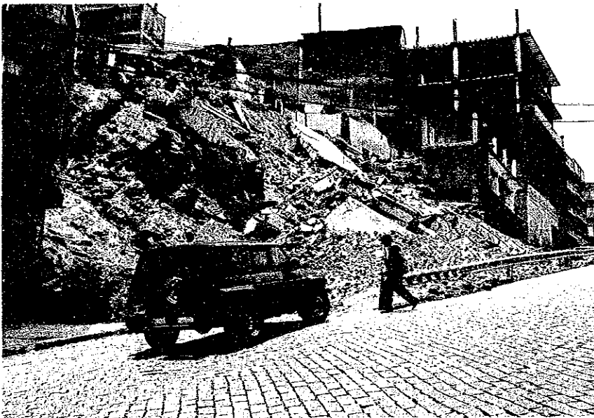
Lugar dañado por el deslave de tierra y vía pavimentada de bloques
