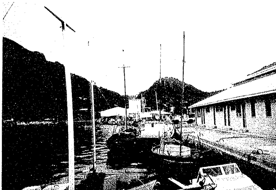
③ 漁業資源調査船用係船岸壁 右の建物はSFAの新設倉庫 (マヘ島, ビクトリア港)
