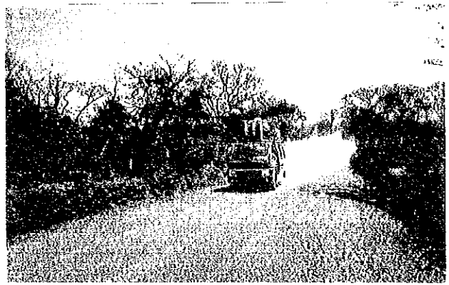
Pendant la saison sèche, après le passage d'un véhicule la visibilité est réduite à zéro à cause de la poussière
