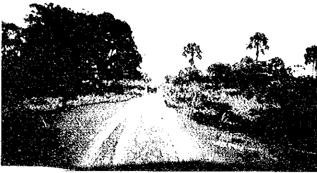
L'évacuation de l'eau de pluie est mauvaise, les flaques se forment sur la route
