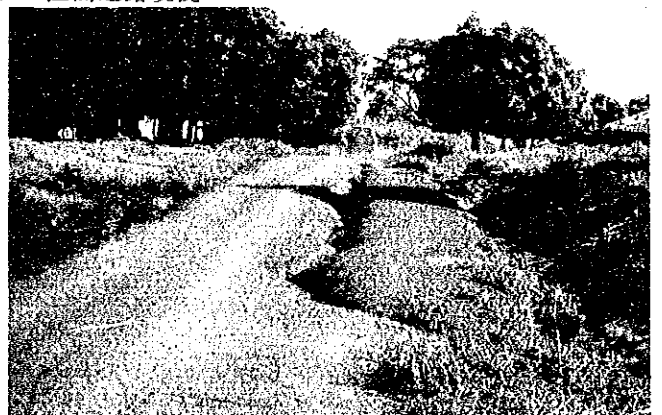
降雨の後、ラテライト道路に亀裂が生じて、路面が破損している。
