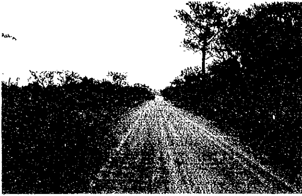
ラテライト土道部が風化し、路面波状凹凸に変化する。
