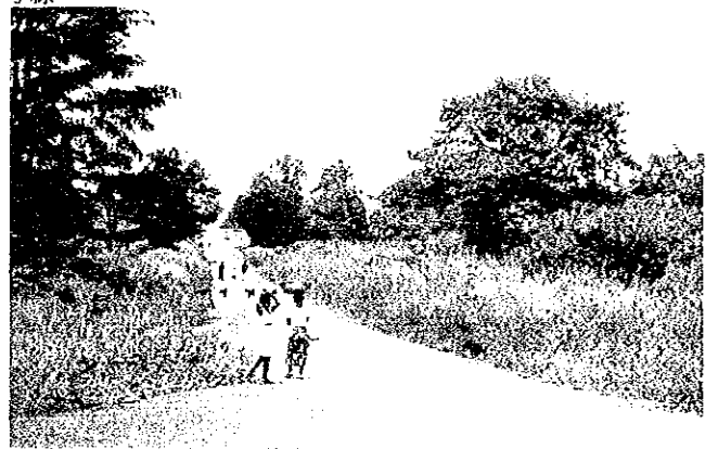
国道3号線 ヤロケ～ボッサンテレ区間道路現況
