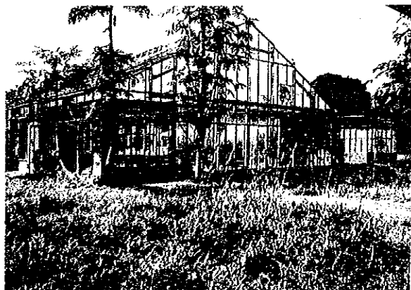
老朽化したガラスハウス
