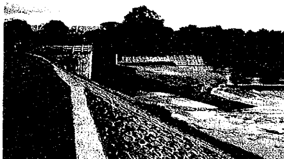
取水堰 (小型水力発電機を持つ)
