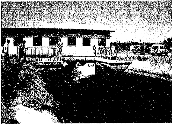
ポンプ揚水場
