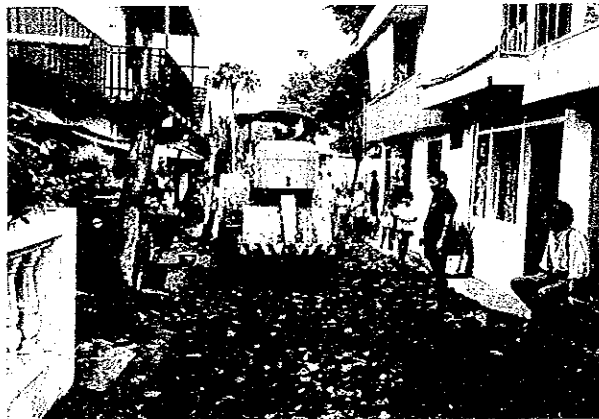
写真5 スラバヤ市内のカンポンの道路整備
