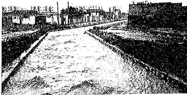
③ Qued Gariana. Vue de l'Amont à partir de la route
