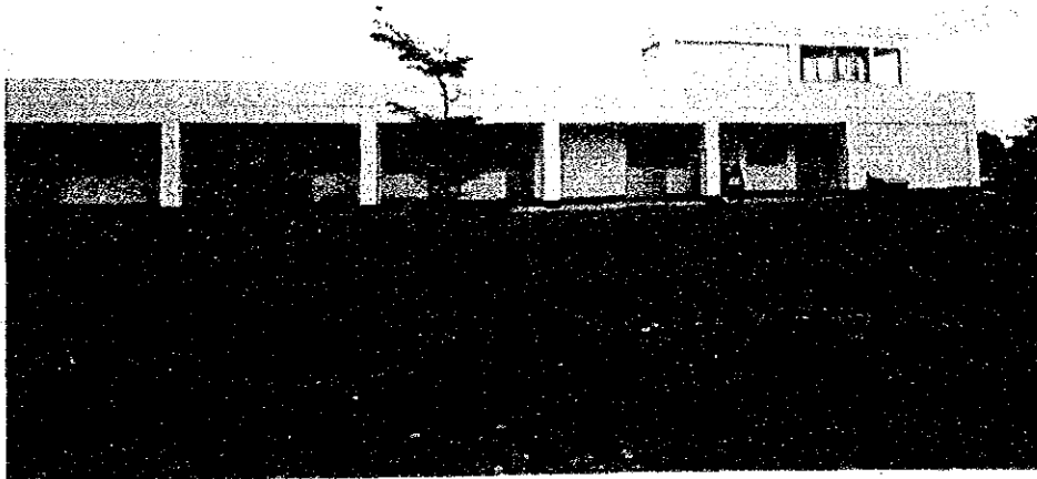
写真-4 海産エビ養殖試験所技術管理棟
