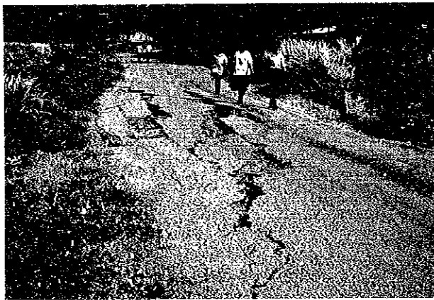
写真6.21 道路の損傷 マウメレから東に向かう道路部分では路面に多数の亀裂が生じた。その多くは細くて長い。この写真に示すのは長さ10m、深さ123cmの亀裂である。
