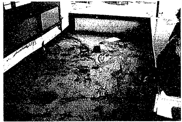
写真6.10 地盤液状化。マウメレ市 マウメレの住宅地域では多数の住居が地盤の液状化現象によって被害を受けた。家屋内部では水と砂の混合物が大量に床下に噴出した。住宅は住むことができなくなった。亀裂は住宅の内外に発生した。
