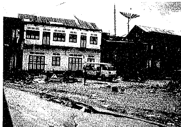
写真6.11 地割れ。マウメレ市 マウメレ市には長く、幅の広い地割れが多数認められた。
