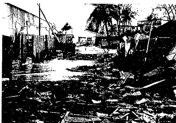
写真6.6 地盤液状化。マウメレ港地盤液状化によって土地が沈下し、道路が冠水した。
