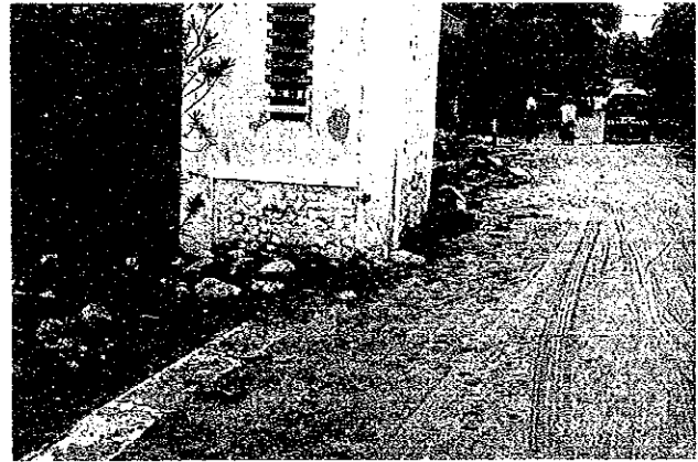
写真5.33 マウメレ港のゲート・ビルの沈下
