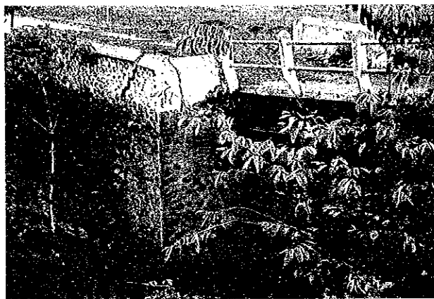
写真5.21 橋台の破損によって起こった桁の沈下
