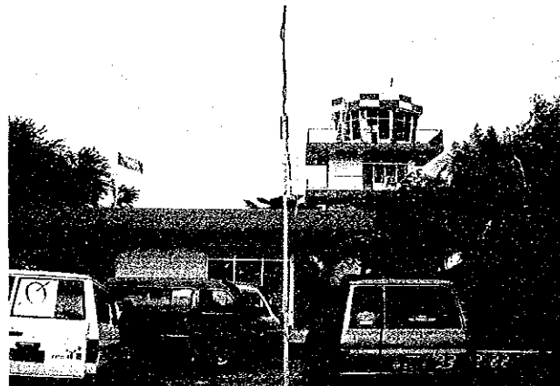
写真5.24 マウメレ空港の管制塔の被害
