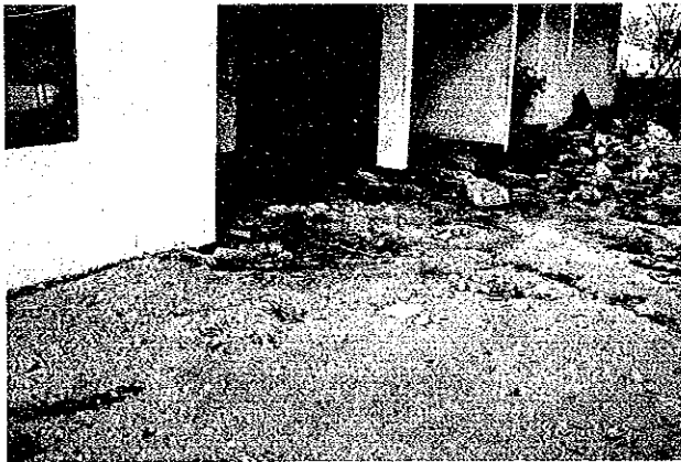
写真5.32 マウメレ港にある建物の基礎の沈下
