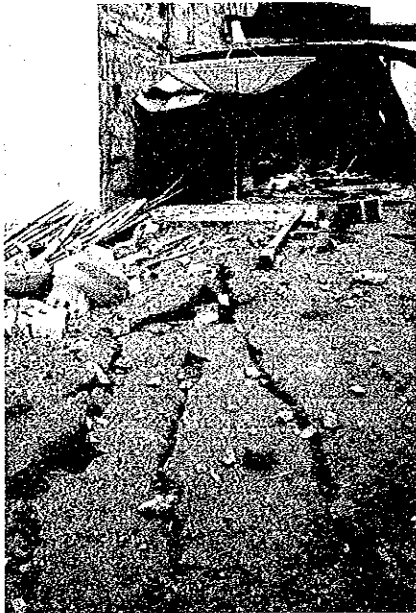
写真5.4 6 海岸に沿って生じた亀裂(マウメレ市)
