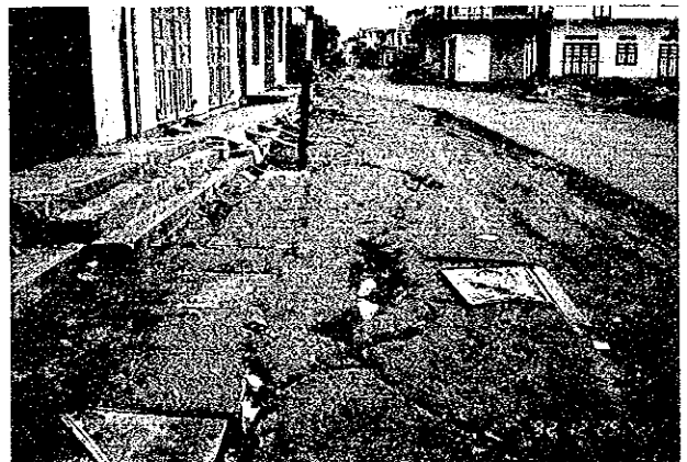
写真5.4 7 海岸に沿った舗装道路に生じた亀裂(マウメレ市)
