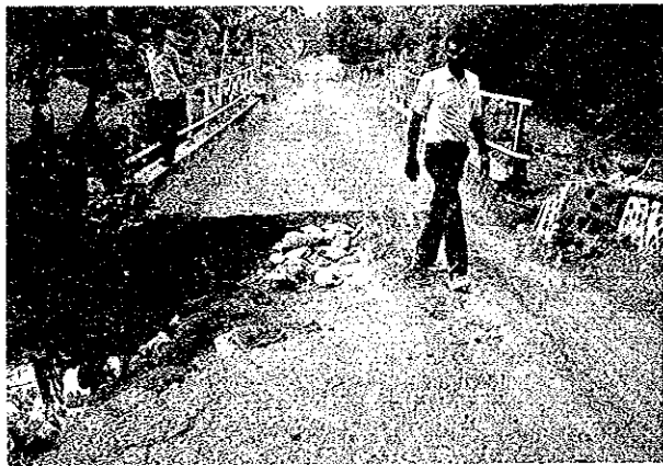
写真5.9 胸壁と背面盛土の崩壊
