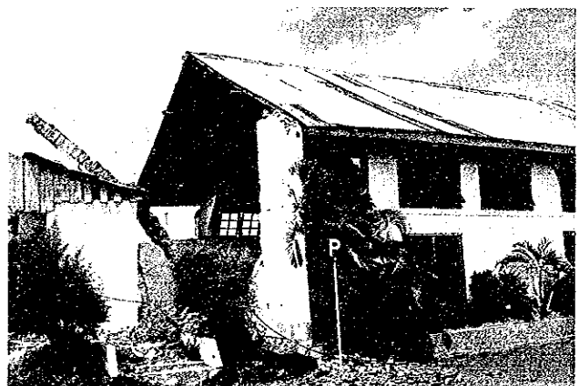
写真4.17 エンデの集会場。側壁が倒壊した。
