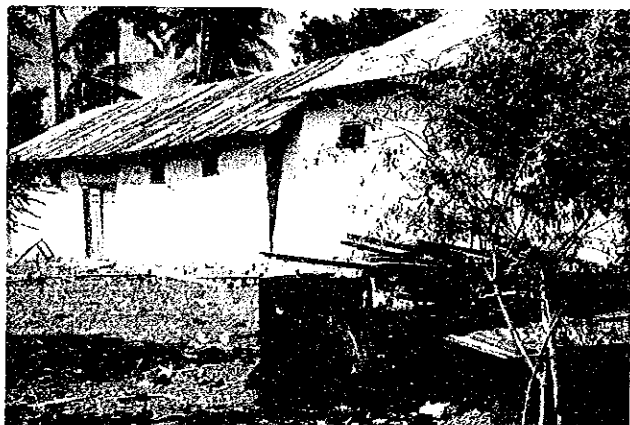
写真4.39 煉瓦造りの倉庫の壁構造が大きな被害を 受けた(面外破壊による)。
