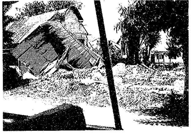
写真4.19 煉瓦壁建物の典型的被害パターン。完全な崩壊。
