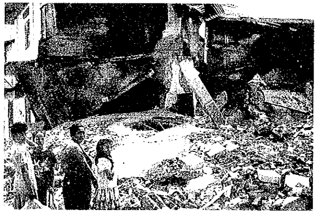
写真4.15 倒壊した鉄筋コンクリート建物
