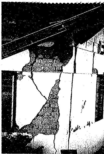
写真4.7 大きな被害を受けた小学校の建物。屋根、木製梁、煉瓦構造、柱、鉄筋コンクリートなどが被害を受けた。
