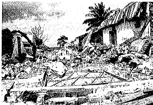
写真4.36 倒壊した煉瓦造りの家屋。マウメレ市にて。
