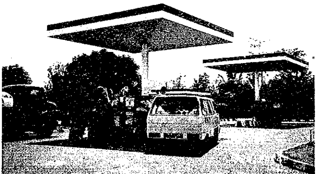
写真4.55 マウメレ市の丘陵の中腹地帯にあるガソリンスタンド。鋼製の屋根は無傷であった。
