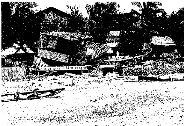
写真4.33 津波によるマウメレ港の被害
