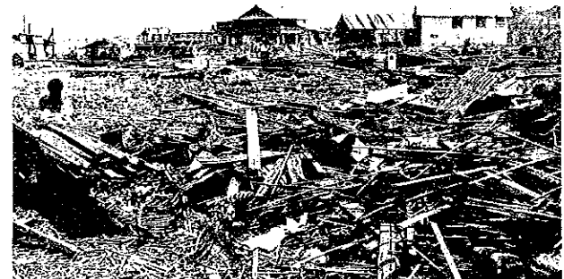
写真4.34 津波によってウリン町(マウメレ市の3km西)は完全に破壊された。
