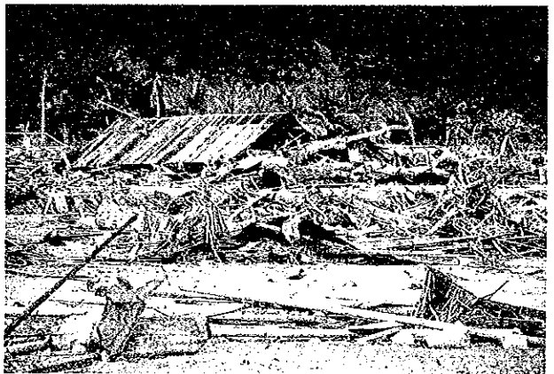
写真4.27 津波によって崩壊した住宅。バビ島、 マウメレ市から30kmの地点。
