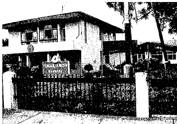
写真4.4 5 2階建て鉄筋コンクリート/煉瓦造りの建物。甚大な被害をこうむったので、執務は仮設のテントで続けられている。
