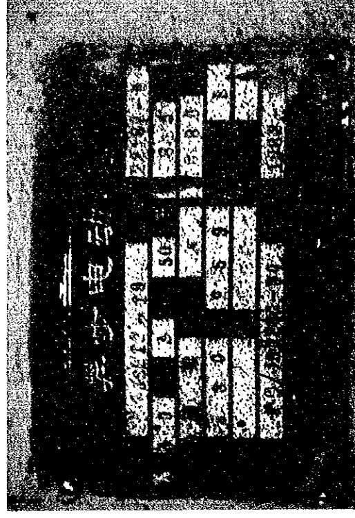
旧浦排水機場のポンプ銘板
