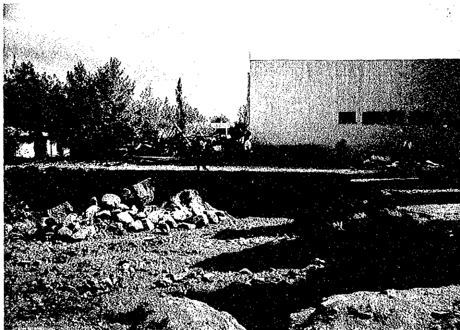
ブルサコミュニケーションセンター建設現場 (右手の建物はコンフェレンスルーム)
