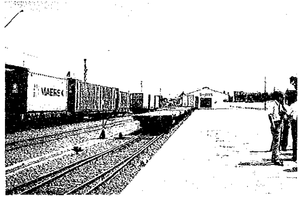
Solo Jebresドライポート、積み下ろし場
