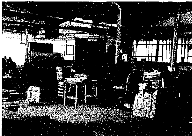
6. 製材所構内 (床材を製造している)
