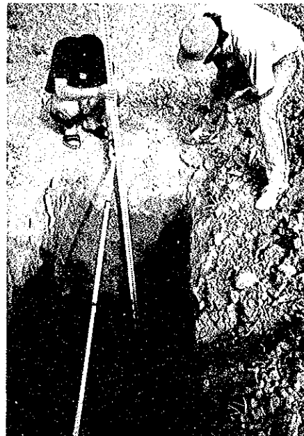
地下水位の観測状況
