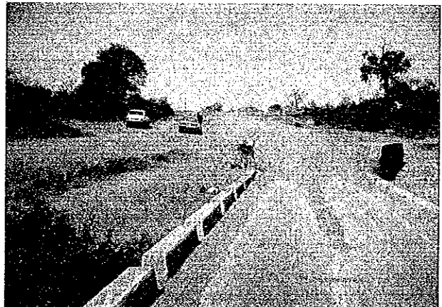
橋梁中心より左岸取付部方向
