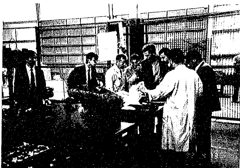
アインボルジャー訓練センター実習棟
