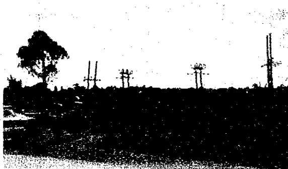
本計画用地（用地内に33kV送電線1回線が通っている）
