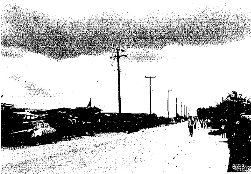
DAR ES SALAAM 11 kV 配電線
