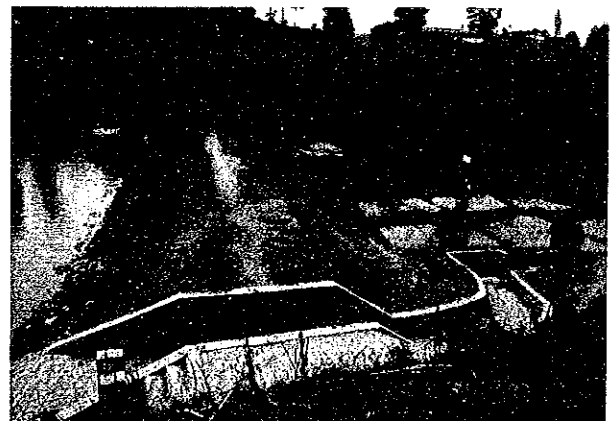
調査地でみられるチェックダムは、小流域からの土砂を堆砂させるとともに、養魚池、水田等の利用にも供される。
