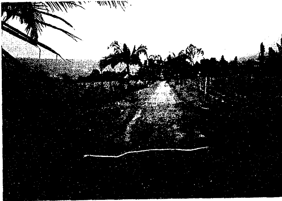
SITUACION ACTUAL DEL CAMINO PRINCIPAL (既設幹線農道の状況)
