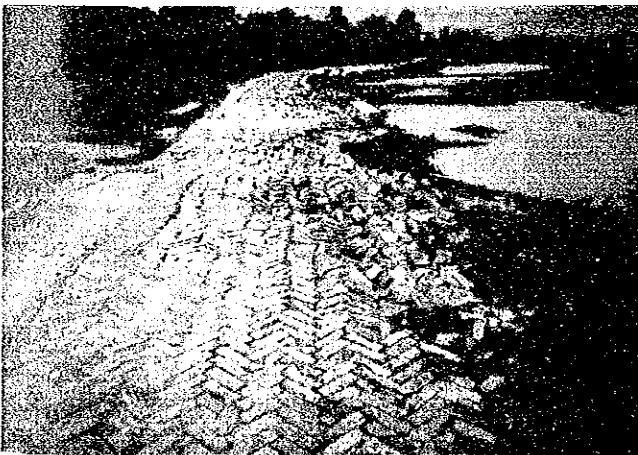
農村道路R1 (フェニ県バルシュラム郡) (1車線、レンガ舗装)
