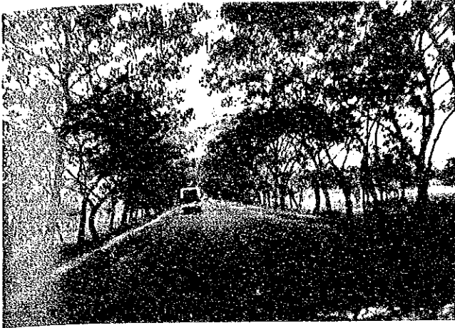
国道 (ダッカ～コミラ間) (2車線、アスファルトコンクリート舗装)
