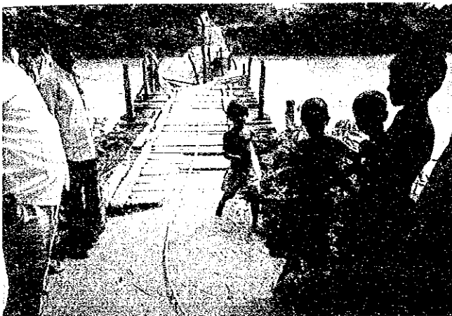
橋梁番号 15-01-01 橋梁中央部が破損して、通行が危険な木製橋梁
