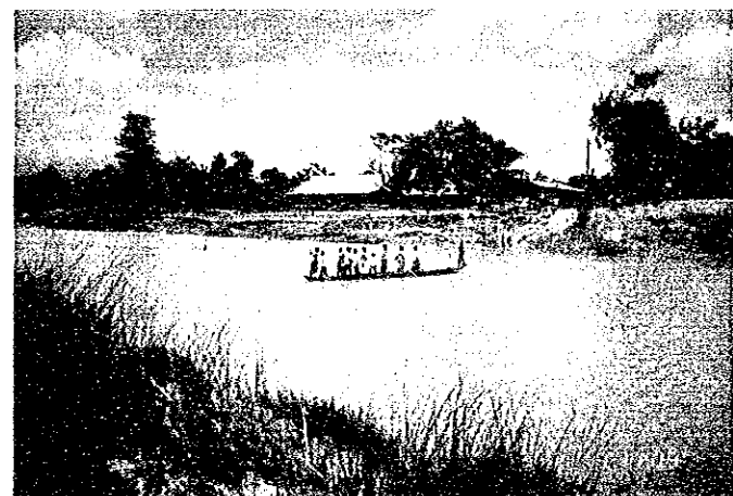
橋梁番号 03-02-01 橋梁がないため小舟により横断している渡河地点
