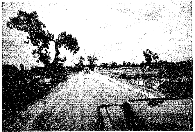
主要地方道路 (フェニ～バルシュラム間) (2車線、浸透式アスファルト舗装)
