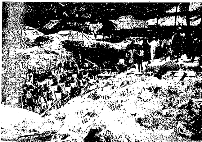
基礎杭(場所打ち杭)施工状況
