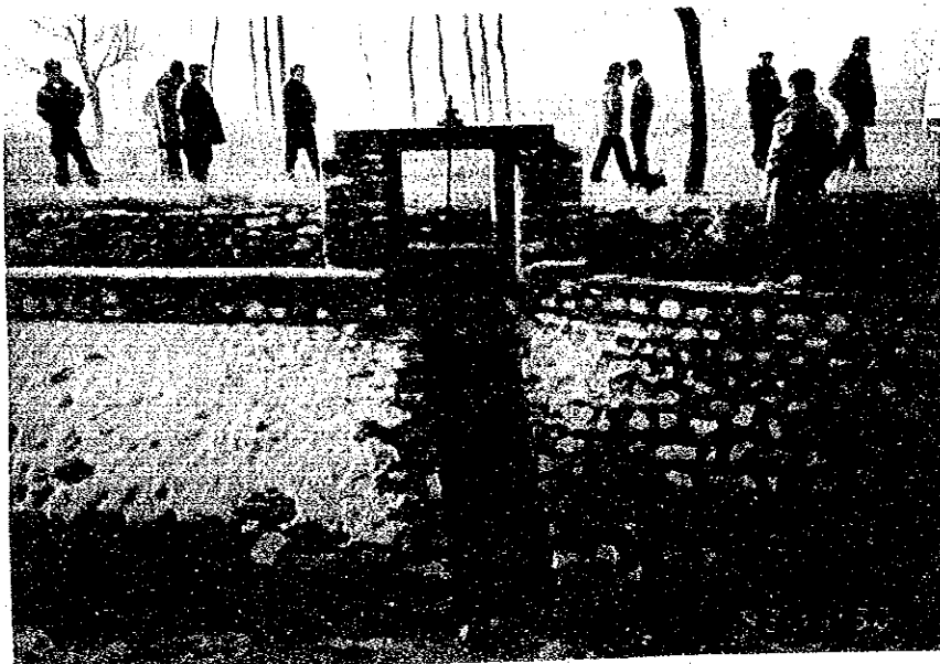
北幹線旧四支分水工
