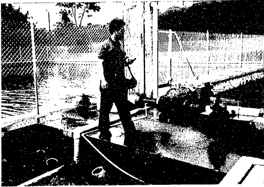
サンタアナ 配水池
