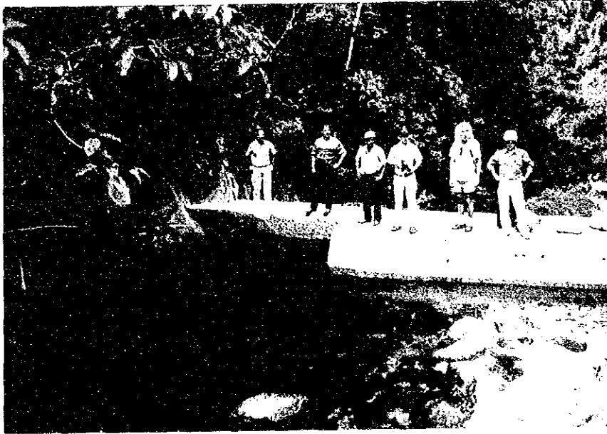
サンタアナ川 取水堰
