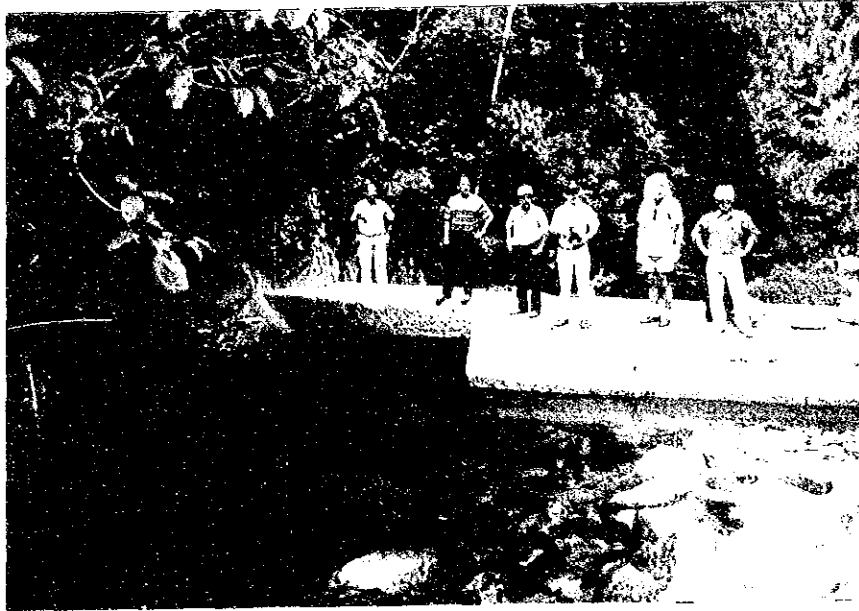
Muro de toma de agua del Rio Santa Ana
