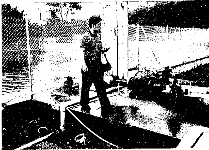
Depósito de distribución de agua del Santa Ana
