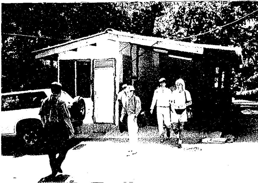
CLORINADOR DE RIO PIEDRAS
