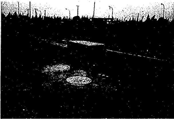
新サイト内 排水受けマス
