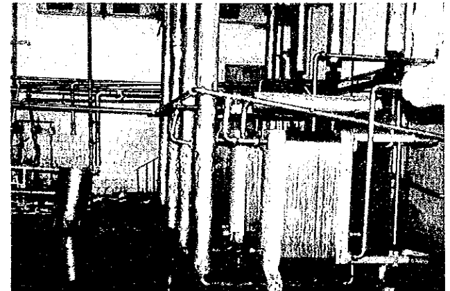
プレート式冷却装置
