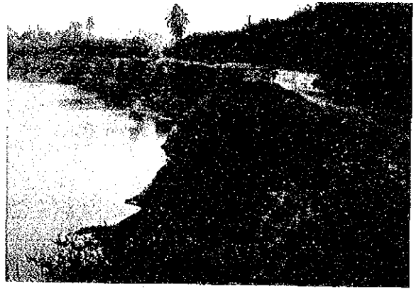
P-20 河岸浸食 (河口より20km上流)
