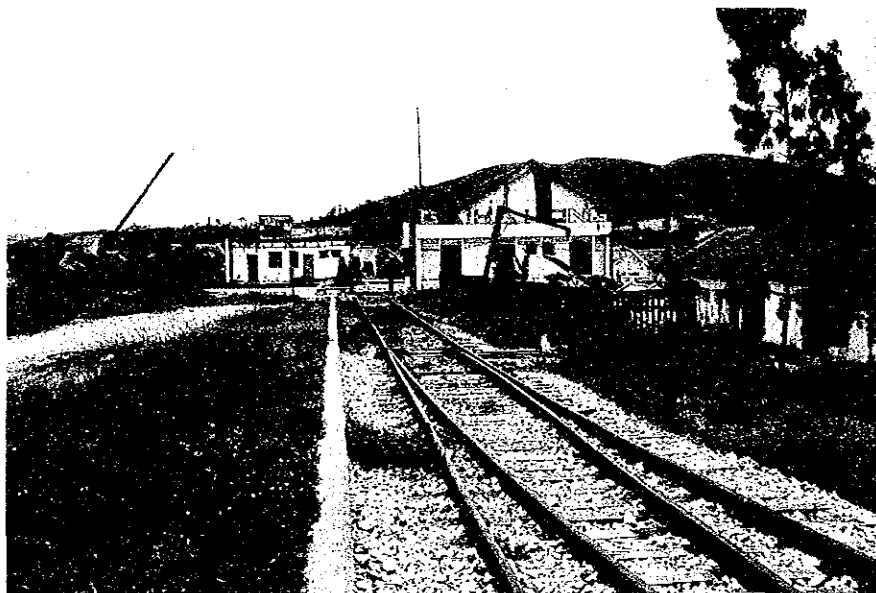
Ha Long 駅。カイラン港手前3.5km地点のこの駅まで鉄道が敷かれている。
