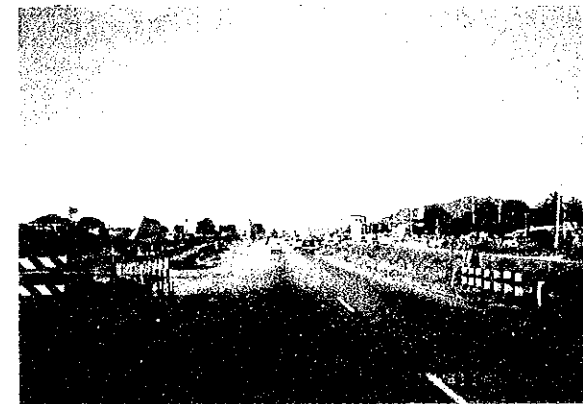
チョンブリ～パタヤ間（国道3号） チョンブリ～パタヤ ハイウェイとの 立体交差IC-4（工事中）付近
