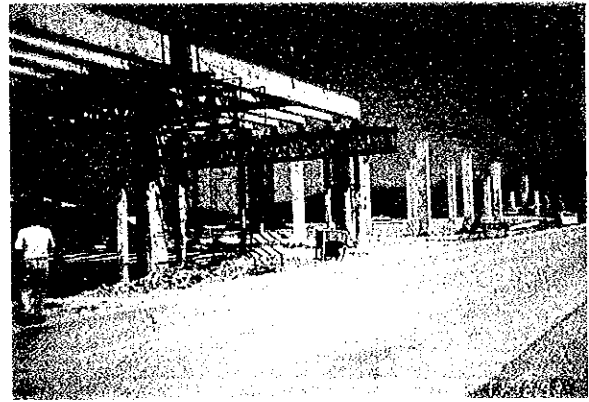
ウタイタニ～ナコンサウン間(国道32号) ウタイタニIC工事中のコンクリート柱 とコンクリート桁
