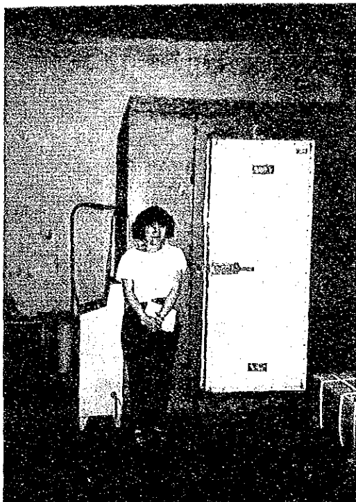
写真-11 小型冷蔵庫（ウォークイン） ポリオ以外のワクチンの保存 に使用温度 温度2～10℃、ほとんどが 中国製、稼働中
