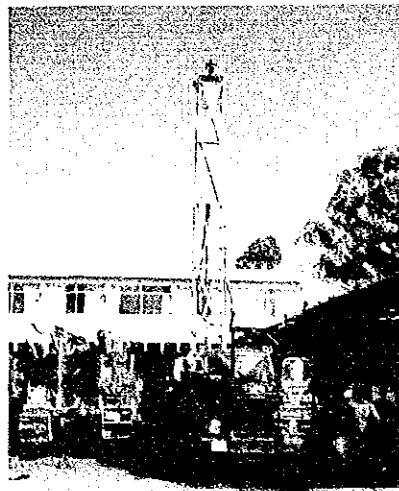
▲ ボーリング会社 Daho Pozos S.A 事務所前のトラック搭載型掘削機
