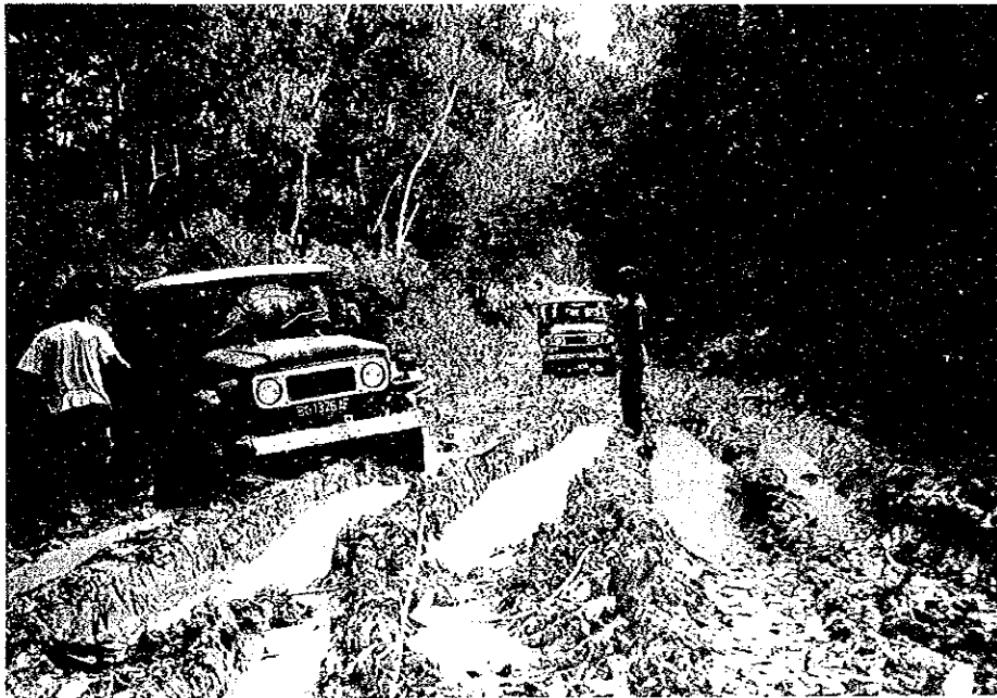
雨期の道路事情（ブナカットサイト内）
