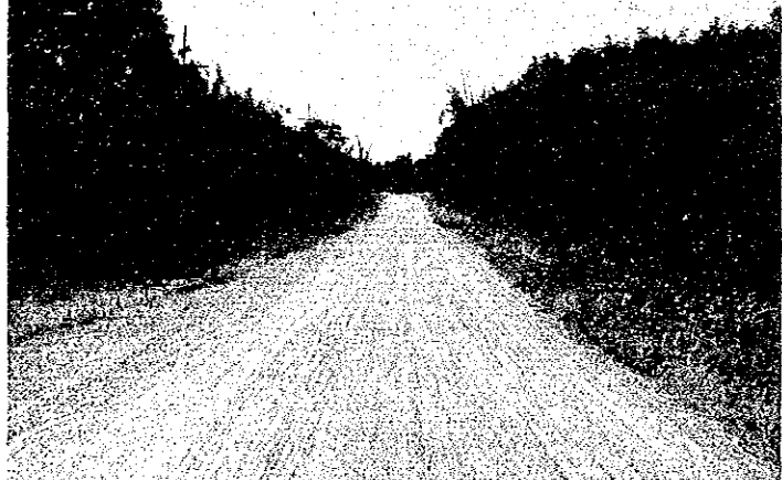
NC-3 ; 国道416号線の現況 (ラテライト道路)
