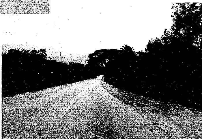
RW7-1 ; 国道4063号線の冠水区間
