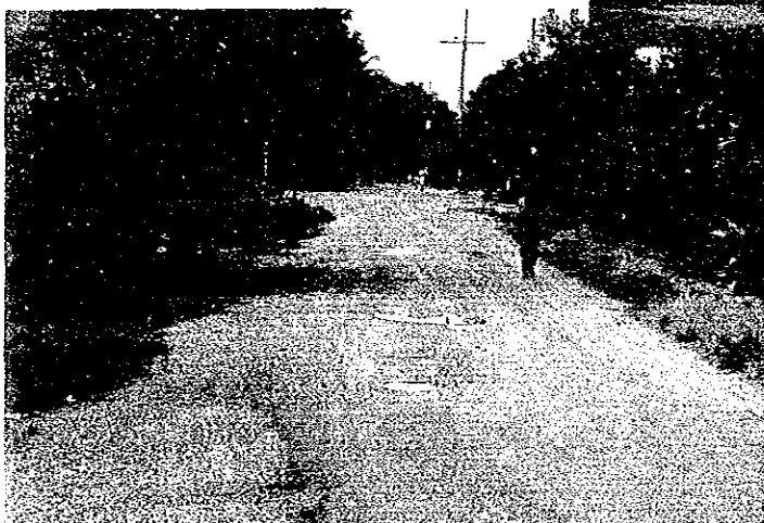
NC-5 ; PWD道路 (ラテライト道路)
