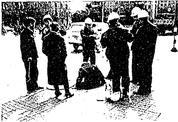
地域配管分岐ステーション (入口マンホール)
