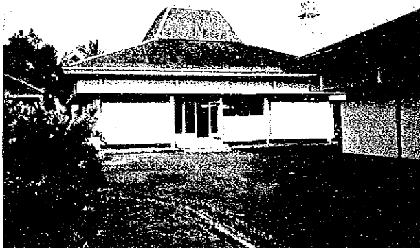
写真-18 土質・コンクリート試験棟
