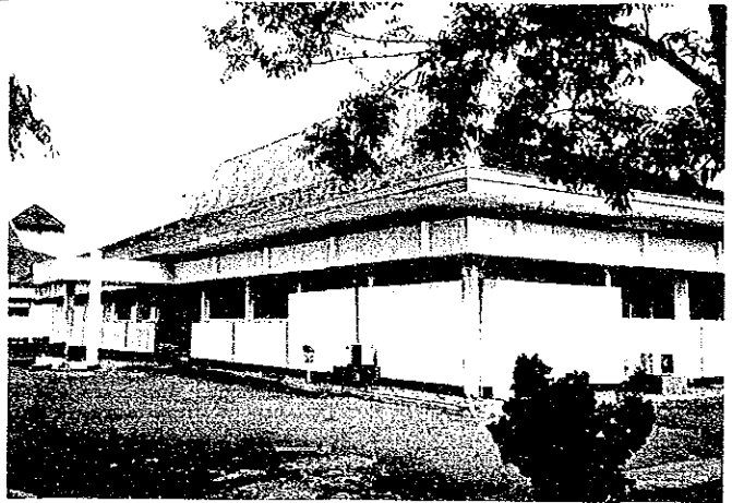
写真-17 本館の近景
