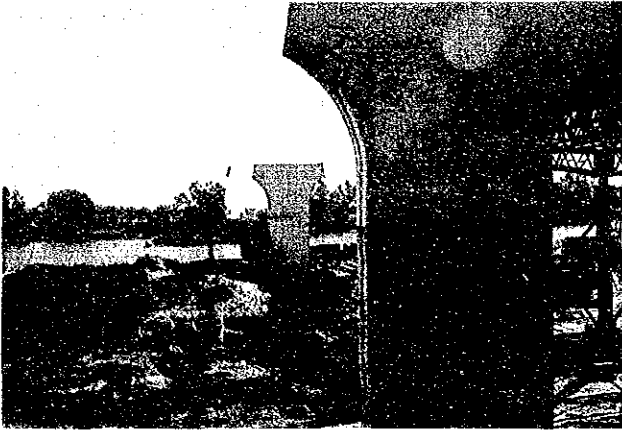
写真3.12.7 Mansula橋（建設中）
