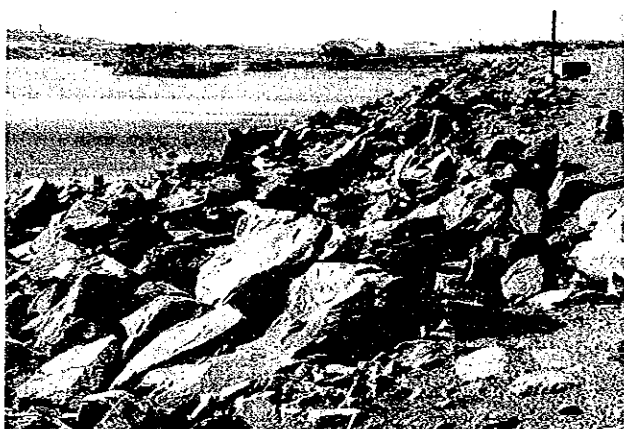
写真3.12.42 巨石が積み上げられたロック部分
