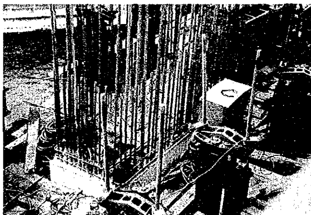
写真3.12.23 配筋（異形鉄筋を用い、帯鉄筋がしっかり曲げ定着されている）
