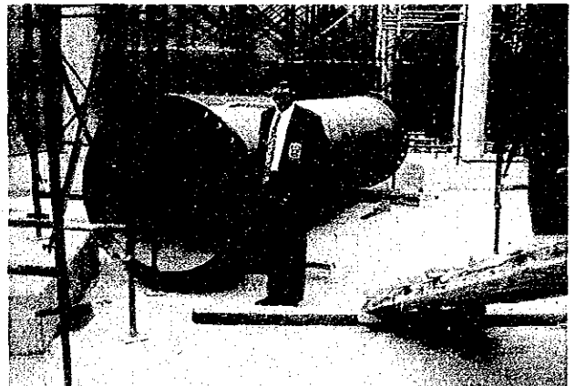
写真3.12.35 配水、注水に用いられるダクタイル管 (径1.2m)
