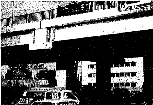
写真3.12.17 カイロ市内の高架橋
