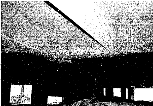
写真3.11.26 住宅建築物における大梁および小梁 （柱芯が不揃いである）
