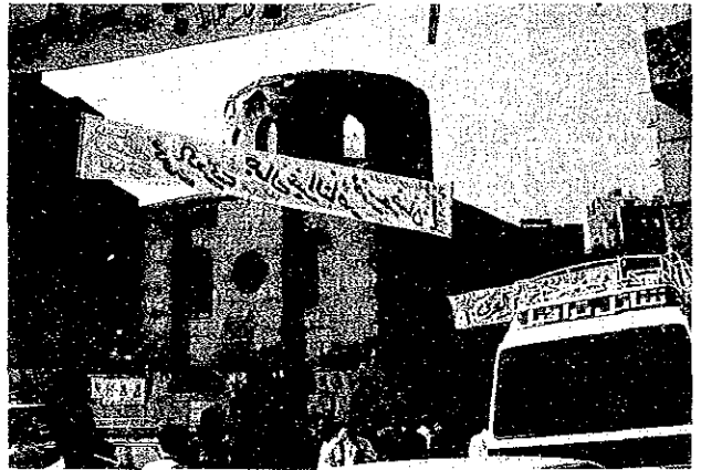
写真3.11.9 石造の古いモスク（頂部のドームは落下した）
