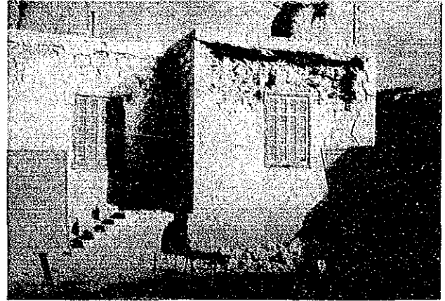
写真3.11.13 石造の学校建築物の被害例
