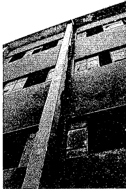
写真3.11.35 衝突により被害の生じた学校建築物 (その2)
