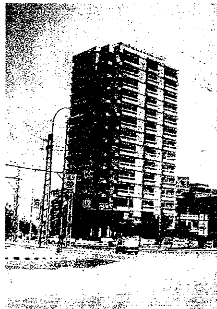
写真3.11.27 崩壊したヘリオポリス14階建住居建築物の地震前の写真（The Egyptian Gazette による）
