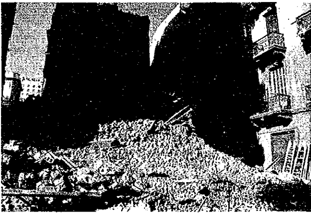
写真3.11.3 泥の山となった5階建無筋組積造住宅建築物 (後方の建築物は同じ形式の建築物)
