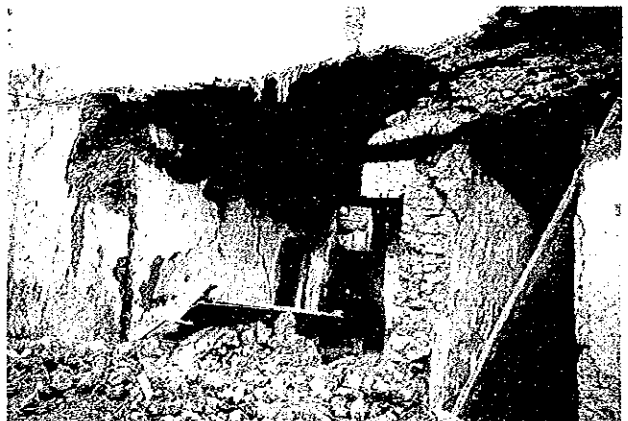
写真3.11.37 農村住宅の被害 (アライアット市周辺)
