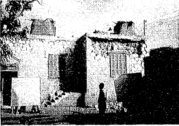
写真3.11.38 ベルワシ村の石造小学校の被害
