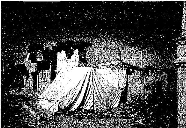
写真3.11.15 崩壊したアドベ造及び避難テント（屋根のある2階部分の被害が極めて多い）
