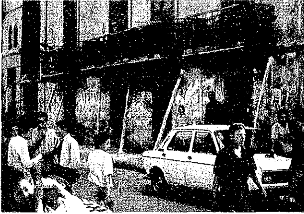
写真3.11.6 無筋組積造に対する木材による応急補強例
