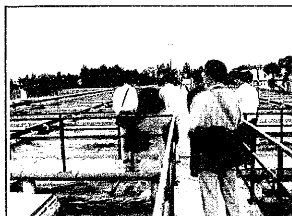
写真5 <DF下水道> ヒロヂ・イ・エストラージ処理場のばっ気槽。
