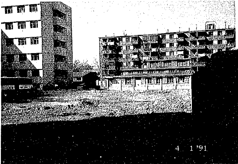
同研究所敷地内あき地 (左上が研究所建物)
