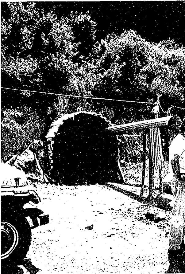
5. ラス・アドフンタス鉱床 立入試験坑道
