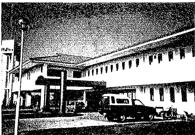
▲ フィルライス本棟 (無償資金協力により1991年3月完成)
