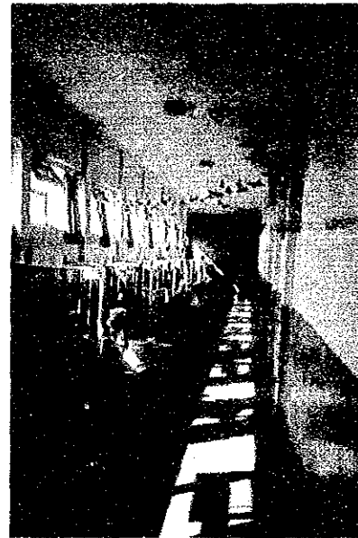
廊下を病室としている
