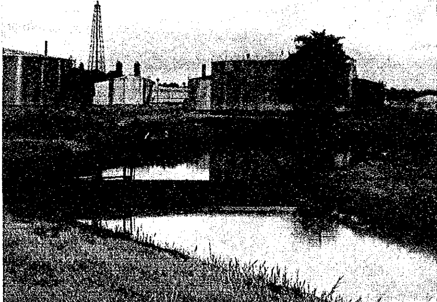
No.2 Guard Basin。No.3、No.4 Guard Basin同様ここにも黒油の跡がある。
