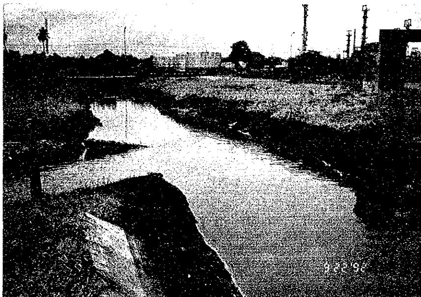
Pointe-a-Pierre製油所No.3、No.4 APIセパレーター出口合流部。
