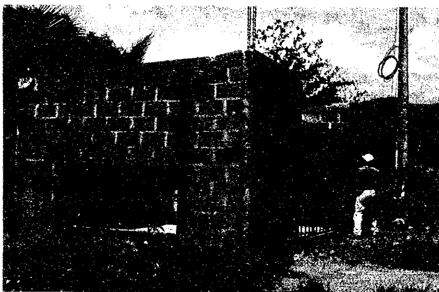
FOTO 7: Caseta de bombas en construcción en el área del Proyecto de mini- riego con aprove- chamiento de aguas subterráneas del MAGA-USAID
