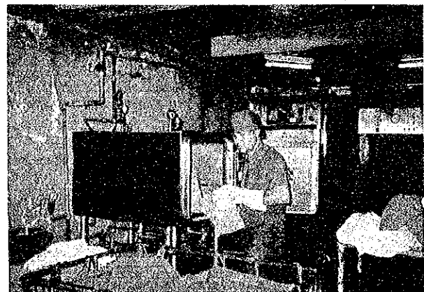
中央材料室：オートクレープが1台故障している。
