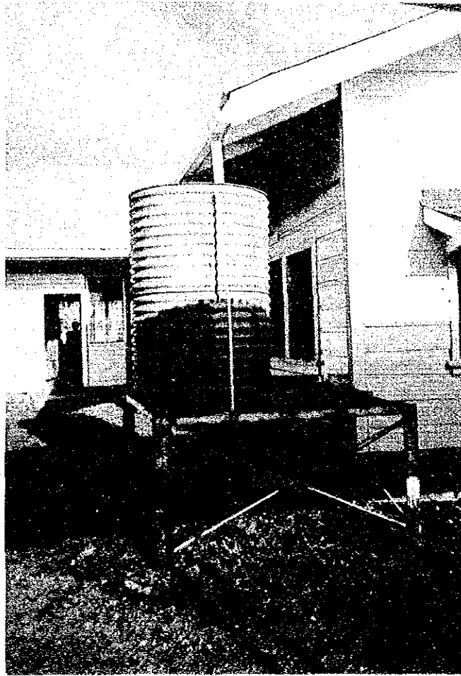
雨水用貯水タンク
