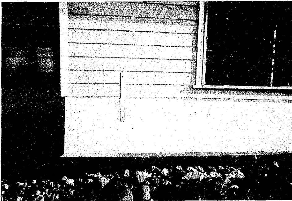
院長宿舎の対サイクロン対策 (コンクリートの土台と建物とを金具で固定)
