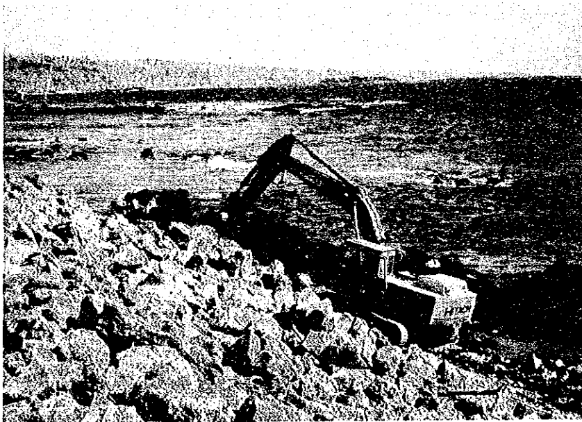
サタウア地方病院護岸工事
